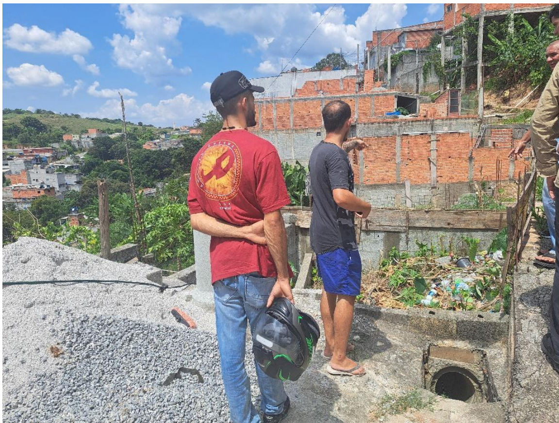
Figura 11 – Vista parcial a partir da Viela Jaguará, na visita in loco , com detalhamento quanto a estrada de concreto construída pelos moradores à direita, tubulação de concreto e casas em construção com restos de lixo e entulho. Fonte: A autora (2024).
