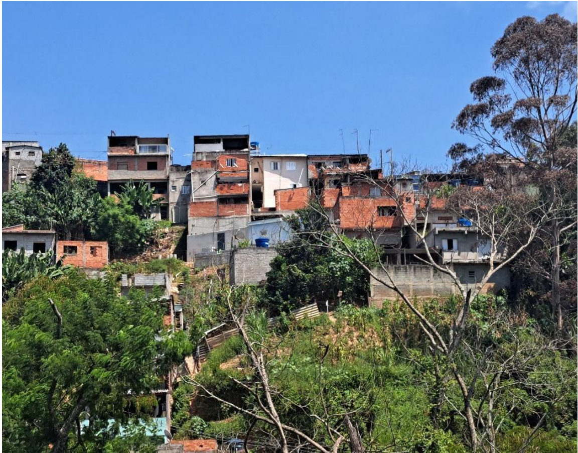
Figura 10 – Vista parcial da comunidade, na visita in loco , a partir da Rua Água da Prata e próxima a jusante.
